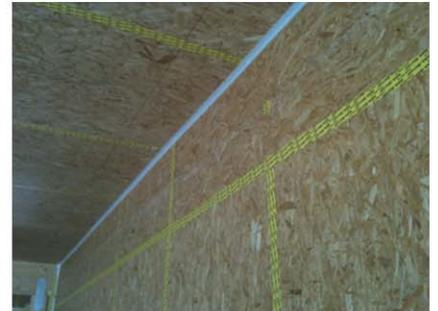
**La membrane d'étanchéité à l'air hygro-régulante.** Il s'agit d'une membrane, composée d'un film quadrillé à base de polymère contrecollé sur un voile non tissé, dont la résistance à la diffusion de la vapeur d'eau varie en fonction de l'humidité relative.
